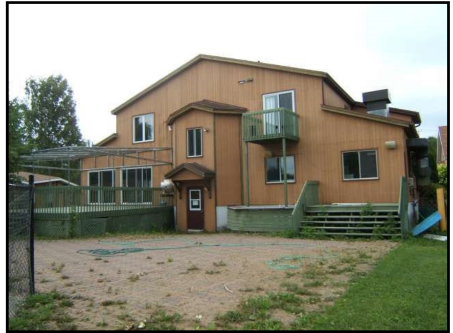
Bâtiment principal ( vue de derrière )
